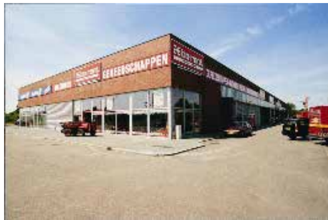
Een simpel bedrijfsgebouw met een overdaad aan illegaal aangebrachte uitingen van reclame die niet aan de criteria voldoen. Bosscherweg 252, Maastricht.
