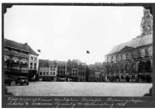
Oude gevel Markt voor doorbraak brug
